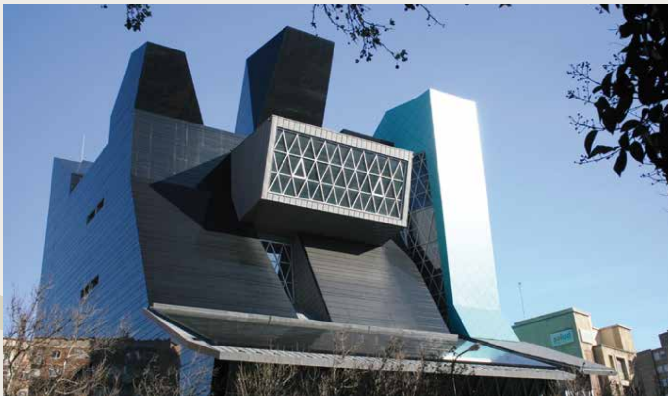
Fachada principal del IAACC Pablo Serrano de Zaragoza
